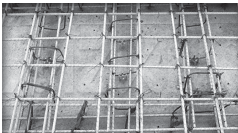
Рисунок 4.3 – Объемный каркас из АНК
