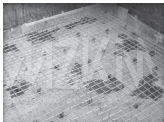
Рисунок 8.3 – Применение АНК для армирования фундаментной плиты 1)
