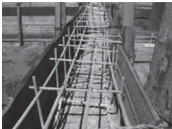
Рисунок 8.6 – Армирование фундамента по периметру сооружения
