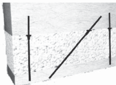
Рисунок Е.5 – Схема установки гибких связей для трехслойных панелей типа «сэндвич»
