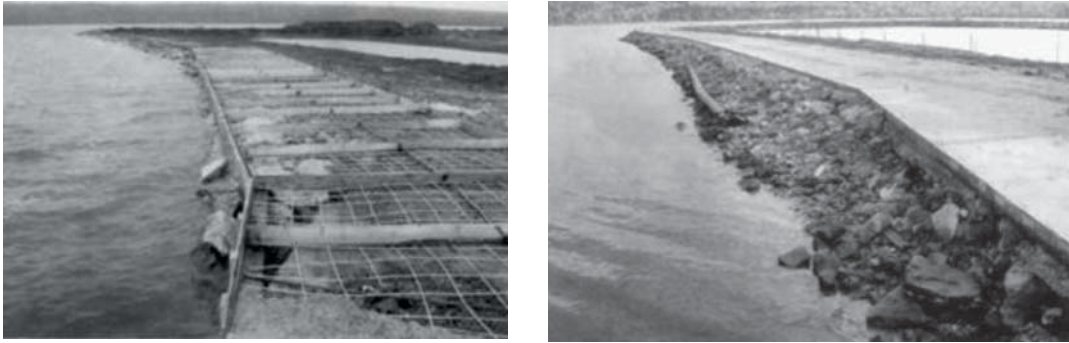
Рисунок 8.23 – Сооружение буны с использованием композитной арматуры 1)
