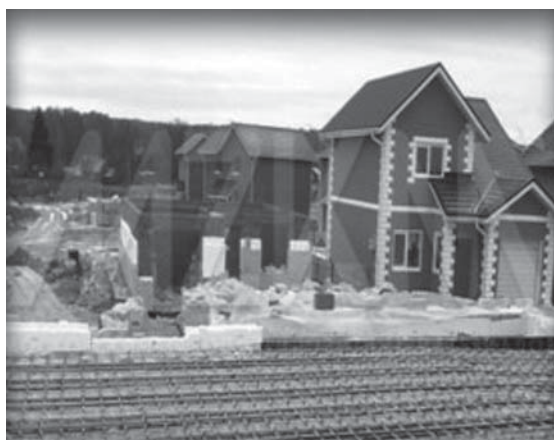
Рисунок 8.3 – Применение АНК для армирования фундаментной плиты 1)
