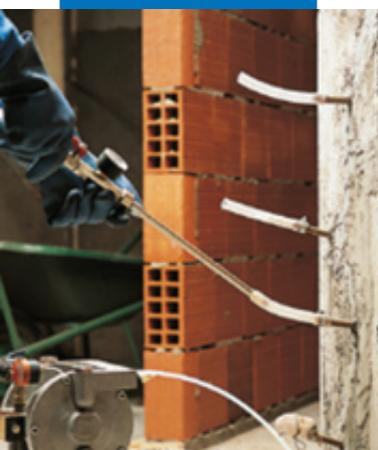
Инъекция Epojet в колонну с трещинами
