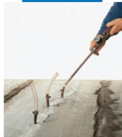
Восстановление горизонтальной конструкции инъекцией E-rojet
