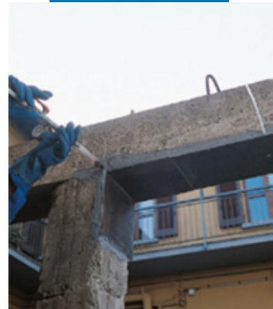
Ремонт балки инъекцией E-rojet
