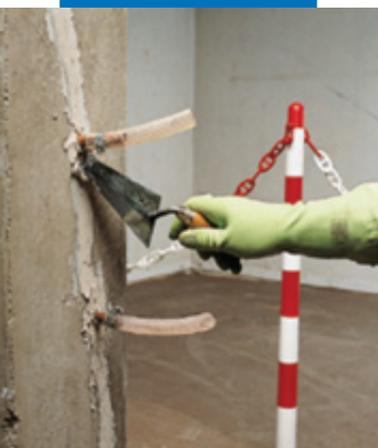
Фиксация инъекторных трубок с помощью Adesilex PG1
