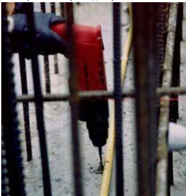
10. Сверловка отверстия для крепежей
